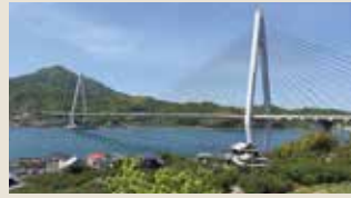
生口島に渡る生口橋
